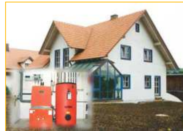
20 kW pompa ciepła-wody gruntowe, Niemcy
